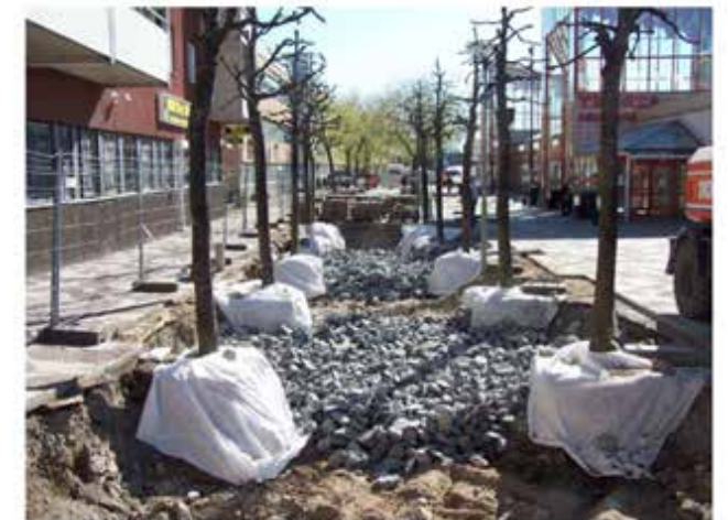
Abb. S.9.3. Konstruktion Schwammstadt
